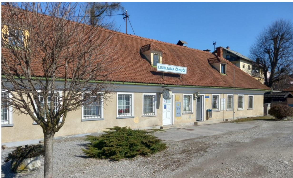
Postajno poslopje železniške postaje Ljubljana Črnuče
